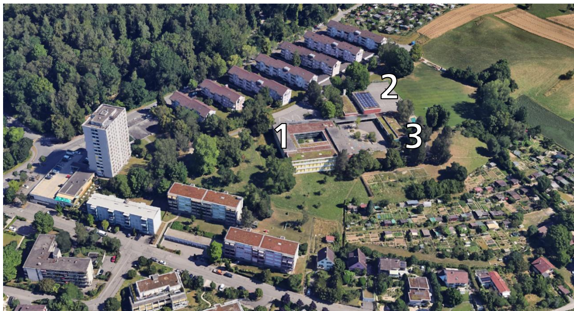
Abbildung 2: Die Schulanlage Alpenblick mit dem Hauptgebäude mit Innenhof / Atriumbau (1), Sporthalle und Aula (2) sowie Garderoben und Hauswartwohnung (3). Quelle: google.ch/maps
